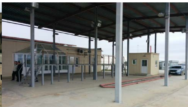
Зона контроля транспортных средств
