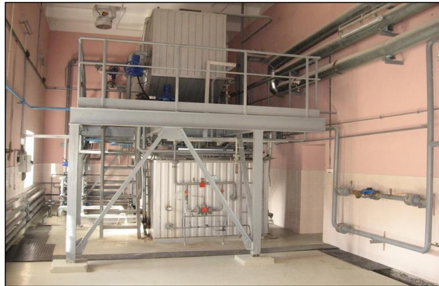
**Коалесцеры – предназначены для разделения углеводородосодержащих отходов по фазам: на нефтепродукт, воду и механическую примесь**
